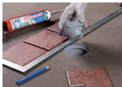
5. Mapesilem AC přilepte bodově na čtyřech místech nástavec na mřížku (s již umístěnou zápachovou uzávěrou). Je důležité, aby podstavec pod mřížku nebyl napevno slepen se silikonovým O-kroužkem, ale pouze na čtyřech místech silikonem, aby všechna voda, která pronikne mezi dlažbu a hydroizolační vrstvu směřovala do vpusti a nehromadila se v jejím okolí
