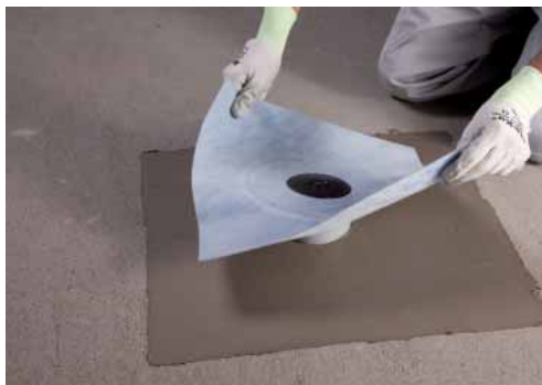
1. Kolem vpusti naneste první vrstvu zvolené hydroizolační stěrky ve větší ploše než je rozměr netkané manžety u Drain Vertical nebo Drain Lateral
