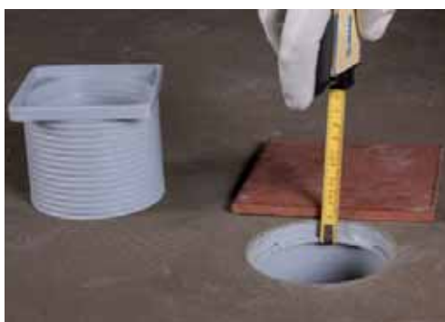
3. Změřte vzdálenost potřebnou pro osazení mřížky do požadované výšky, počítejte s tloušťkou lepidla a dlažby
