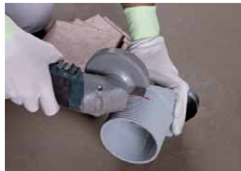
4. Na vyznačeném místě řežte rozbrušovací pilou nástavec na požadovanou délku
