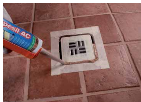
6. Po nalepení a spárování dlažby vyplňte Mapesilem AC spáru kolem mřížky podlahového odtoku
